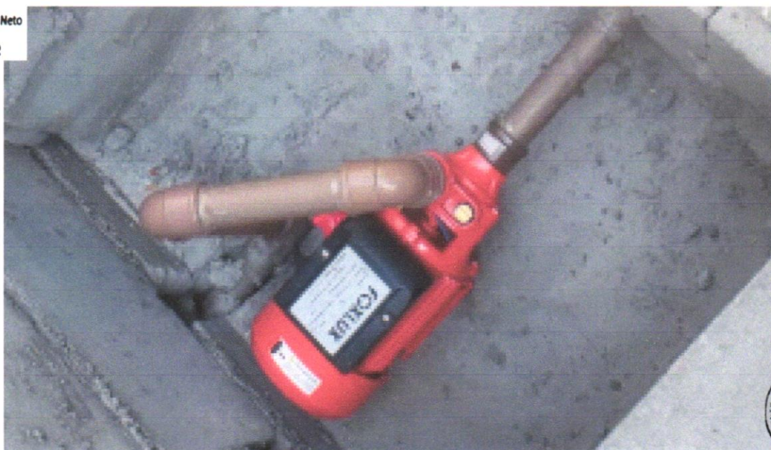
Foto 24 - BOMBA CENTRÍFUGA, MONOFÁSICA, 0,5 CV OU 0,49 HP, HM 6 A 20*M, Q 1,2 A 8,3 M3/H - FORNECIMENTO E INSTALAÇÃO. AF_12/2020
