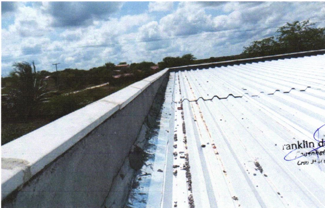
FOTO 02 – Rufo em chapa aço galvanizado nº24 com desenvolvimento 25cm
