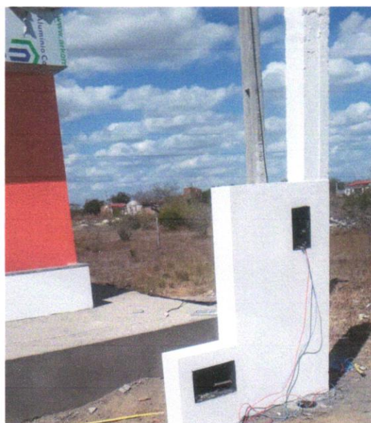
Foto 15 - APLICAÇÃO MANUAL DE PINTURA COM TINTA LÁTEX ACRÍLICA EM PAREDES, DUAS DEMÃOS. AF_06/2014
