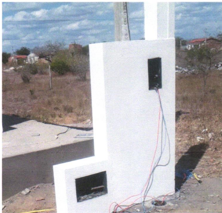
Foto 15 - (COMPOSIÇÃO REPRESENTATIVA) EXECUÇÃO DE ESTRUTURAS DE CONCRETO ARMADO, PARA EDIFICAÇÃO HABITACIONAL UNIFAMILIAR TÉRREA (CASA EM EMPREENDIMENTOS), FCK = 25 MPA. AF_01/2017
