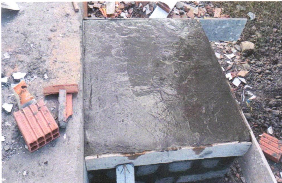
Foto 11 - Fossa séptica pré-moldada, tipo oms, capacidade 20 pessoas (v=1410 litros)
