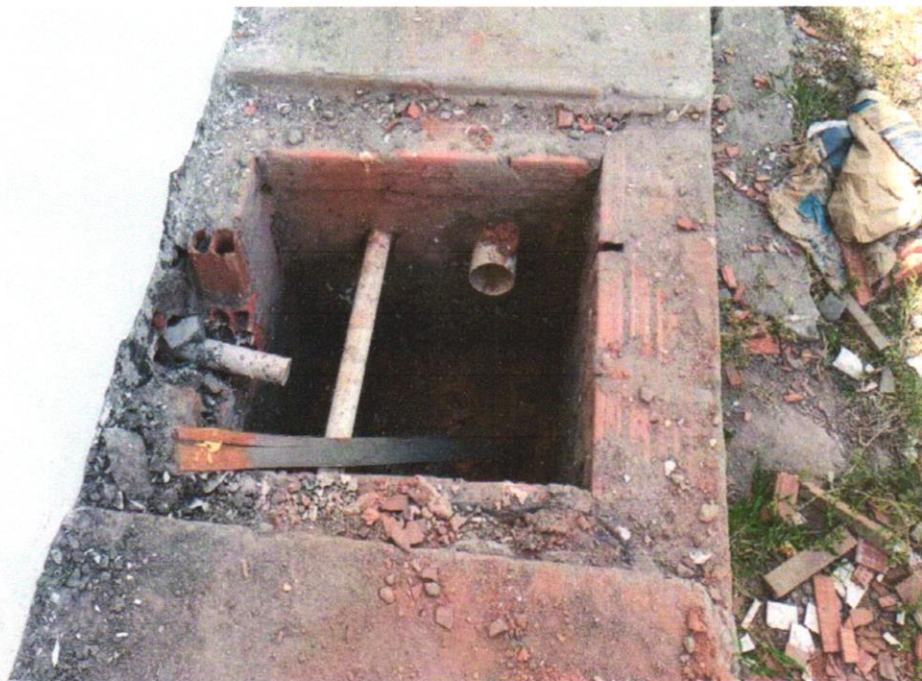
Foto 13 - Caixa de inspeção 0,30 x 0,30 x 0,40m
