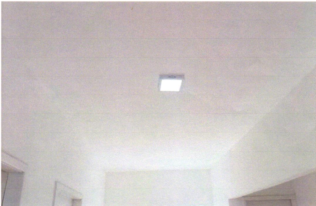
FOTO 01 – Forro de gesso comum, em placas 60x60 cm, inclusive madeiramento com ripões 3,5cm x 5,5cm, instalado
