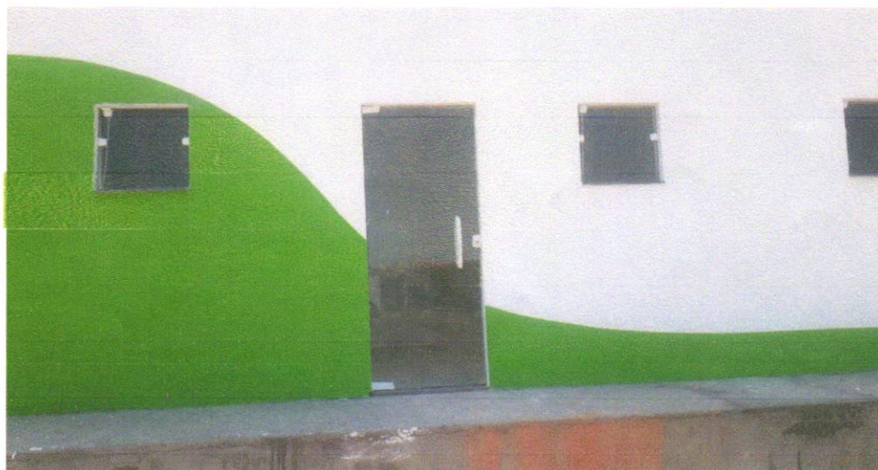
Foto 19 - Porta em vidro temperado 10mm, incolor, inclusive ferragens de fixação e instalação, exclusive puxador - Rev 01_10/2021
