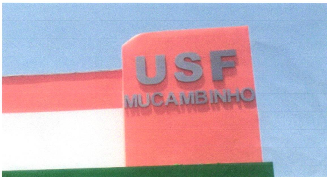
Foto 23 - Letra em alumínio 45 x 45cm - instalado
