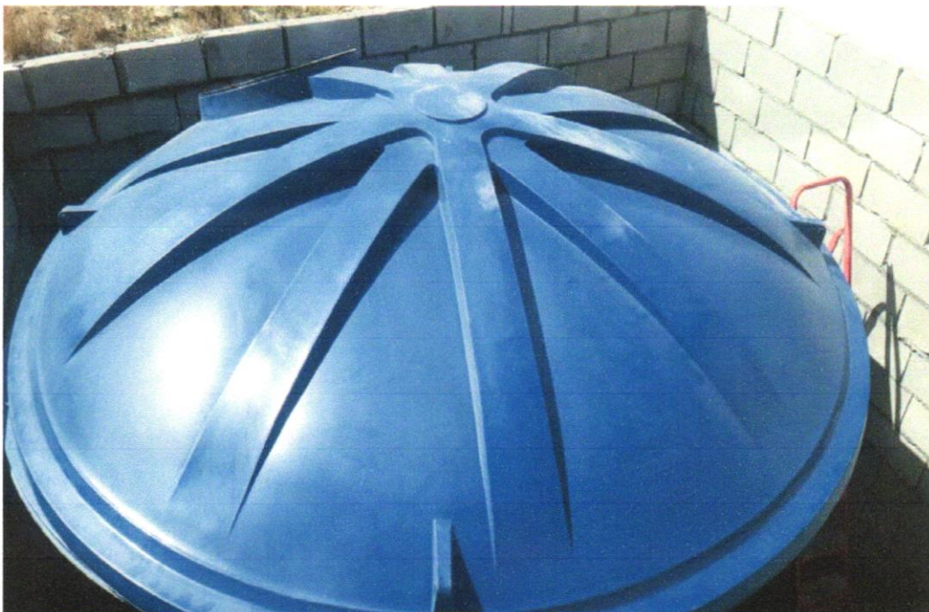
Foto 08 - RESERVATÓRIO DE POLIETILENO 10.000 LITROS
